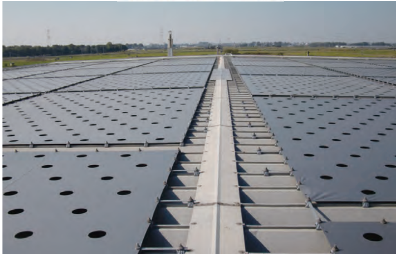
施工事例：工場
