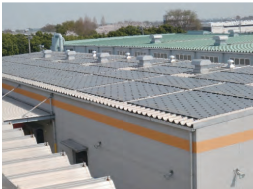
施工事例：倉庫
