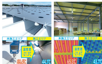
シングル折板の温度事例写真
