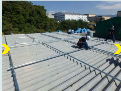
② 鋼材でシートを固定する 枠組みを設置
