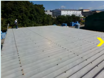
①屋根上のボルトに専用金具を取付
