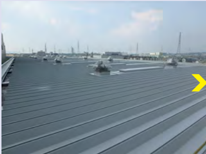
① 墨出しの後、専用金具を配置
