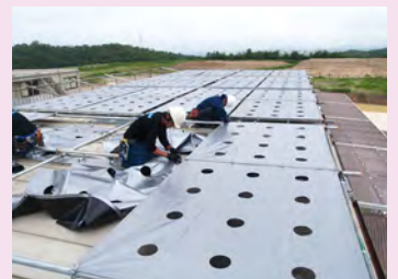
愛知県 現場事務所 その他 ユニットハウス
