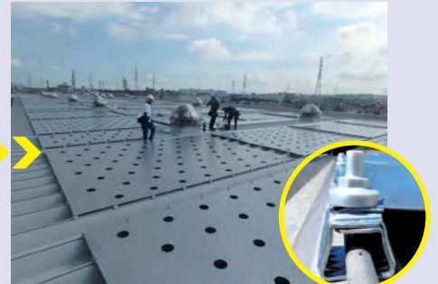
③ 金具を増締めの後、防錆用キャップを取付けて完了
