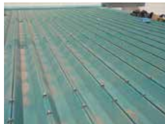
既存設置場所シート撤去完了
