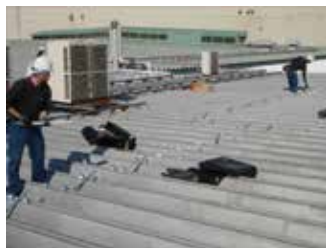
新規設置場所施工中
