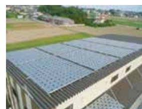
弊社埼玉営業所へ移設
