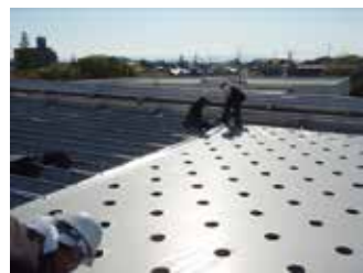
新規設置場所シート取付中
