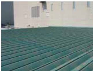
既存設置場所撤去完了後
