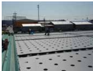
既存設置場所撤去中
